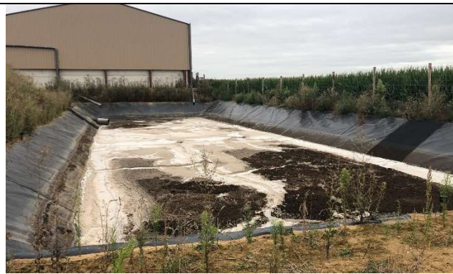
Figure 2 : Bassin de décantation
